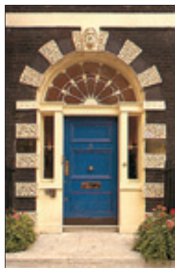
Une porte sur Bedford Square (1775)
