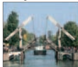
Pont basculant traditionnel
